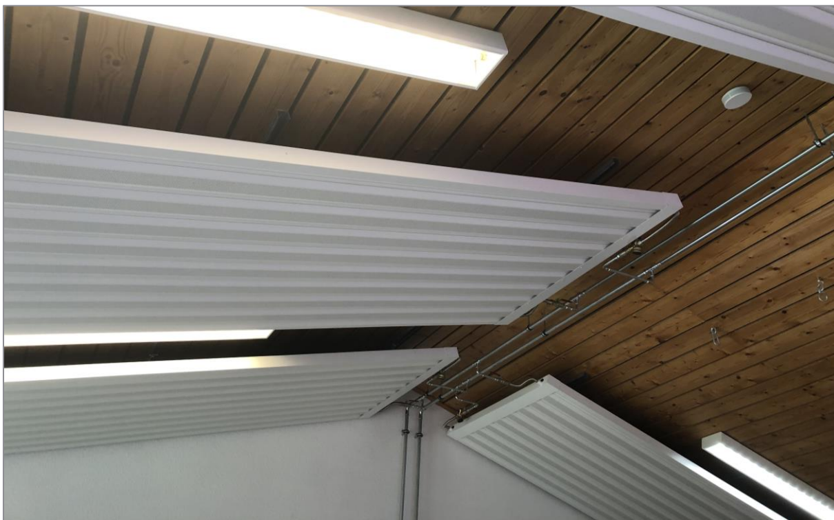
Abbildung 47: Flächenheizkörper an der Decke des Sportraums
