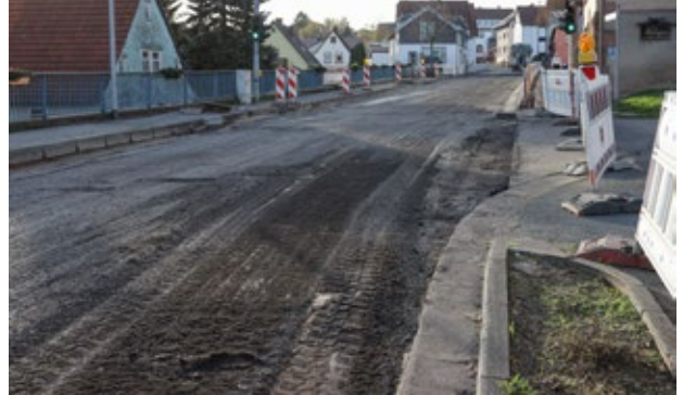
Sanierung der Ortsdurchfahrt Siedelsbrunn
