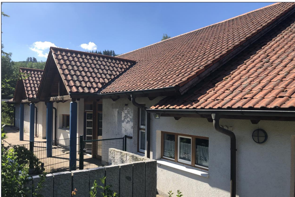
Abbildung 46: Außenansicht Kindergarten Aschbach
