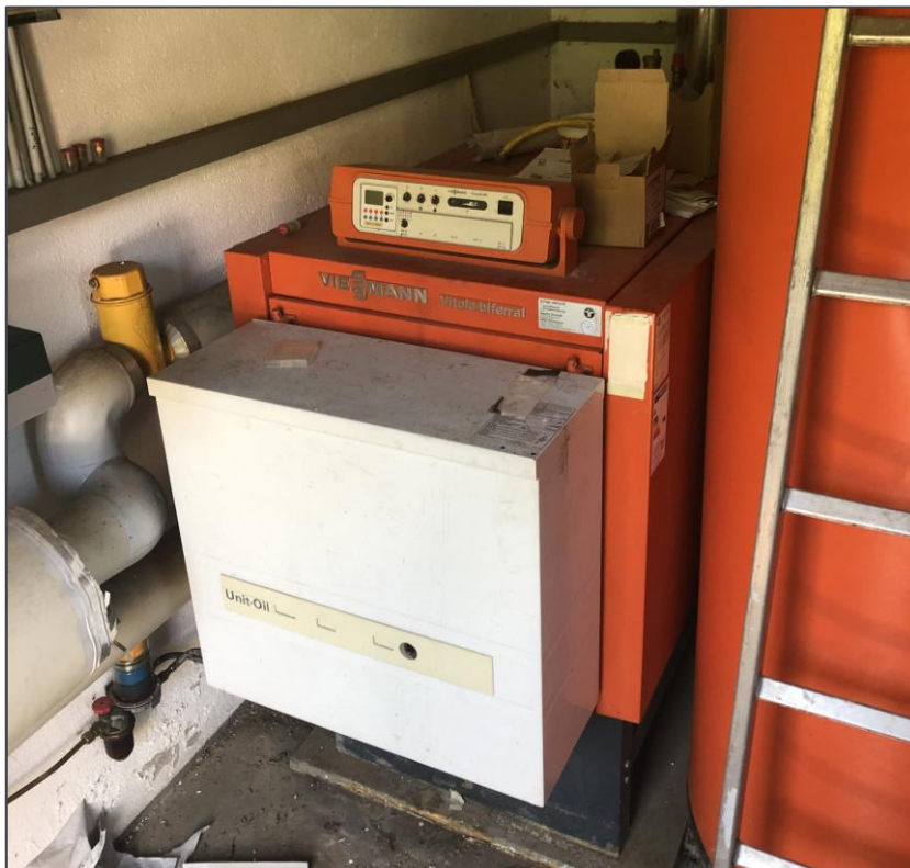
Abbildung 48: Öl-Heizung von 1992
