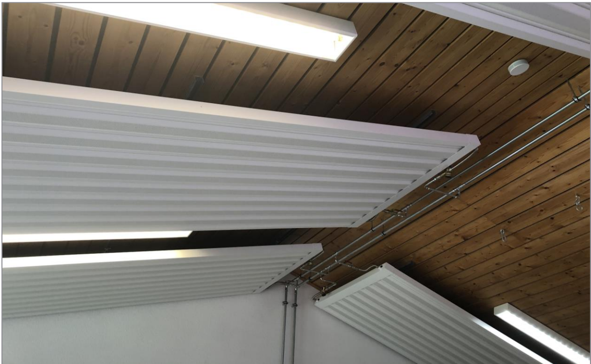
Abbildung 47: Flächenheizkörper an der Decke des Sportraums
