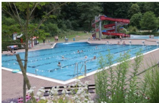
Sanierung im Waldschwimmbad
